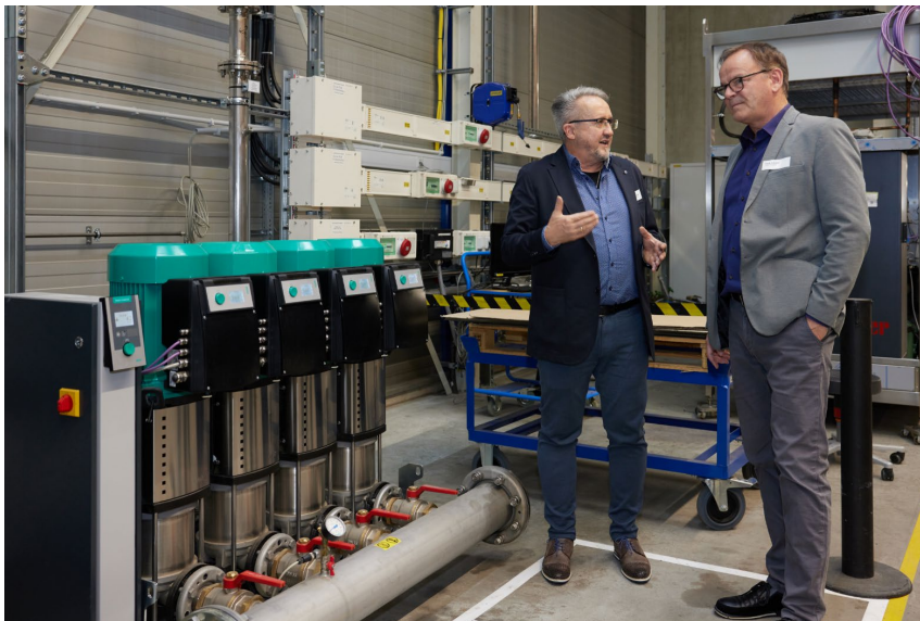
Bild 3: Daniel Huber (Vorstandsvorsitzender der Peter Huber Kältemaschinenbau SE) zeigt Landrat Frank Scherer die optimierte Pumpenanlage, welche die Effektivität der Wärmerückgewinnung verbessert.
