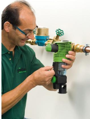
Eingangswasserfilter wie die der Baureihe BOXER® von Grünbeck verhindern, dass kleine Feststoffpartikel in die Hausinstallation eingeschwemmt werden. Auch noch so kleine Schwemmpartikel können zu schwerwiegenden Korrosionsschäden in den Leitungen oder an den Armaturen führen und die Funktion von Trinkwassererwärmern oder Brauseköpfen beeinträchtigen.
