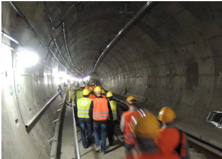
Die Teilnehmer des GEFMA SummerLoungin' besichtigen die Baustelle City-Tunnel Leipzig.
