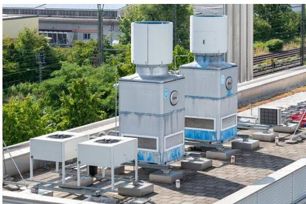
Bei Legionellen-Ausbrüchen werden auch Rückkühlwerke immer wieder als Quelle für Infektionen ausgemacht. Um dieses Risiko zu minimieren, enthält die 42. Bundesimmissionsschutzverordnung (42. BImSchV) eine Reihe von Vorgaben für Errichtung, Beschaffenheit und Betrieb von Verdunstungskühlanlagen, Nassabscheidern und Kühltürmen. So müssen
