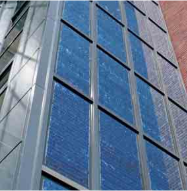
Polykristalline Photovoltaikmodule, vollflächig integriert
