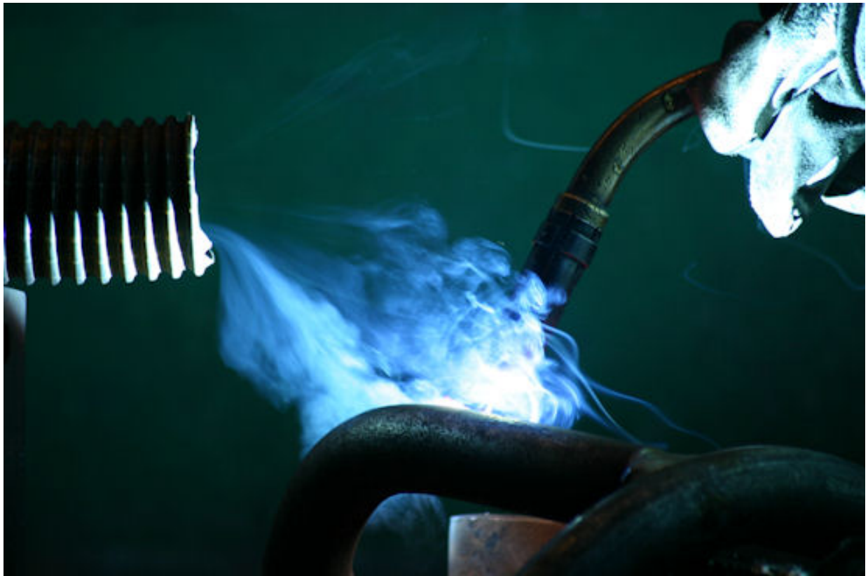
Die Absaugung von Gasen, Rauchen und Stäuben beim Schweißen gehört zum Arbeitsschutz Foto: Jörg Ulm, Burscheid
