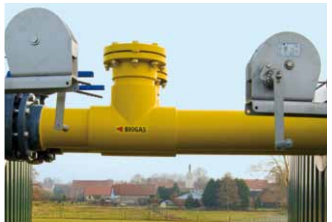
Die erneuerte Gasleitung mit dem Ort Samswegen im Hintergrund.
