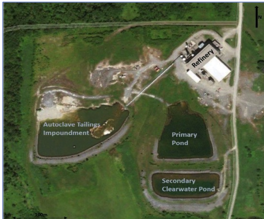
Bild 1. Luftbild der Anlage zur Veranschaulichung des vorhandenen Footprints des Raffineriegebäudes und der Absetzteiche.
