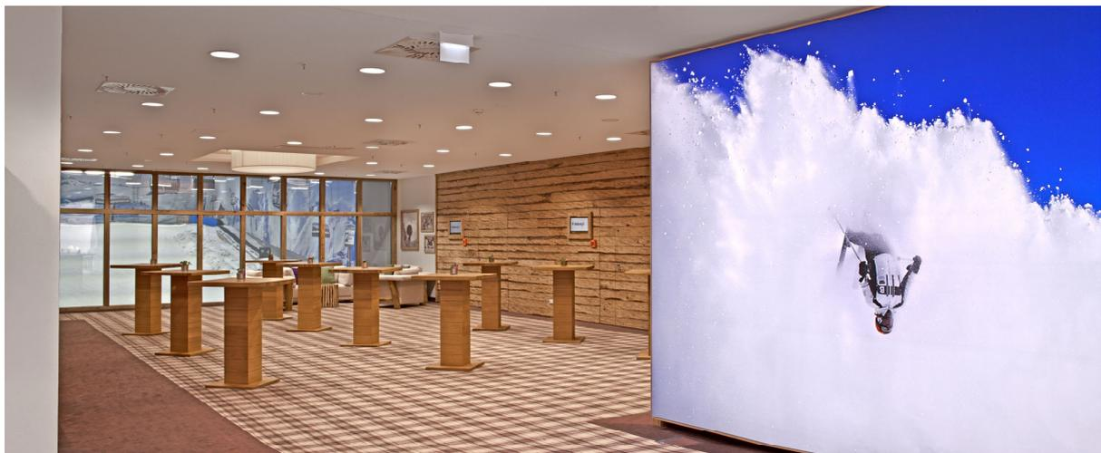
Die Einbauten für Belüftung und Beleuchtung sind nahezu flächenbündig in die Akustikdecke integriert.
