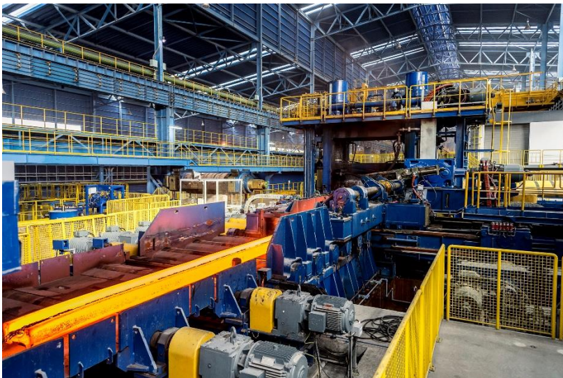
BD(Break Down)-Gerüst aus dem Hause SMS group.
