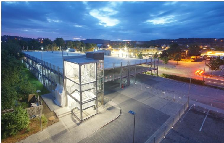
*Bildunterschrift:* Mit dem modularen Preflex® Parkhaus lassen sich bestehende Parkflächen überbauen. So entstehen zusätzliche Stellplätze – sowohl für PKW als auch für LKW. (Foto: C + P)
