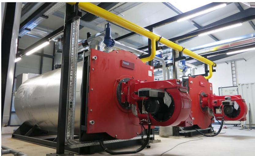
Bild 3: Die Hoval Erdgaskessel im Einsatz.
