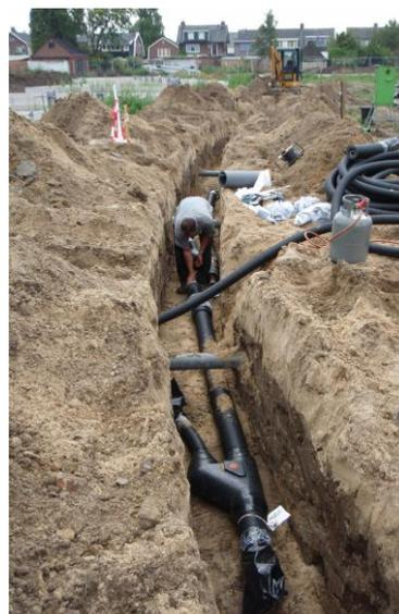
Ein Nahwärme-Rohrsystem mit bereits vorgefertigten, isolierten Abzweigungen wie FlexaLink™ spart bei der Verlegung bis zu 75 Prozent an Arbeitszeit ein.
