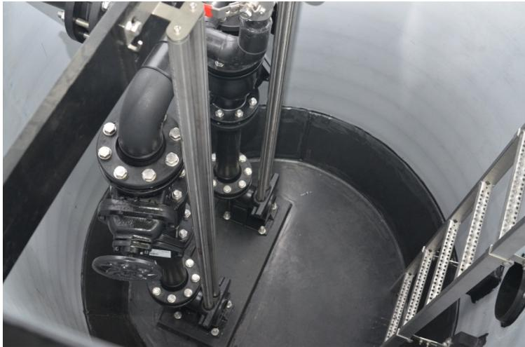
Bild 3: Blick in das Innere. Hochwertige Einbauten sichern eine zuverlässige Funktion der Pumpstation. Helle Oberflächen vereinfachen die Sichtkontrolle.
