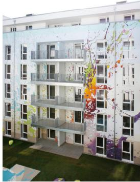
Die Wahl der passenden Farbe stellte eine besondere Herausforderung dar, weil die Gestaltung auf dem Oberputz eines Wärmedämm-Verbundsystems erfolgte. Sie fiel auf die Fassadenfarbe Muresko. Die Siliconharzfarbe auf SilaCryl-Basis hat einen mineralischen Charakter und zeichnet sich durch hervorragende bauphysikalische Eigenschaften aus.
