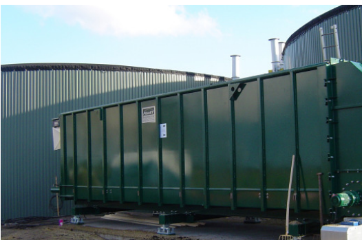
1) PlanET Biogasanlage Weimann in Müden
