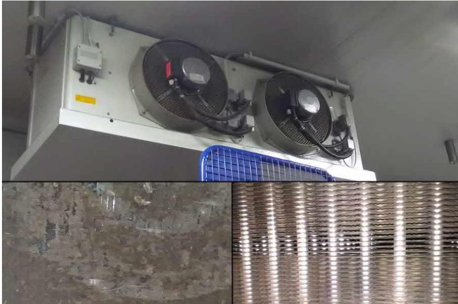
Bild 4: Wärmetauscher eingesetzt im Lagerbereich von Lebensmitteln oben Außenansicht, unten links vor Reinigung, unten rechts nach Reinigung
