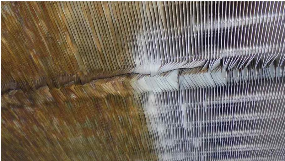
Bild 2: Lamellenwärmetauscher einer Molkerei, links vor und rechts nach der Reinigung
