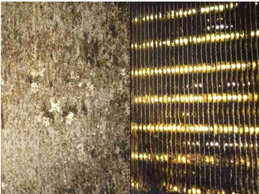
Bild 3: Wärmetauscher in der Fleischproduktion vor und nach der Reinigung
