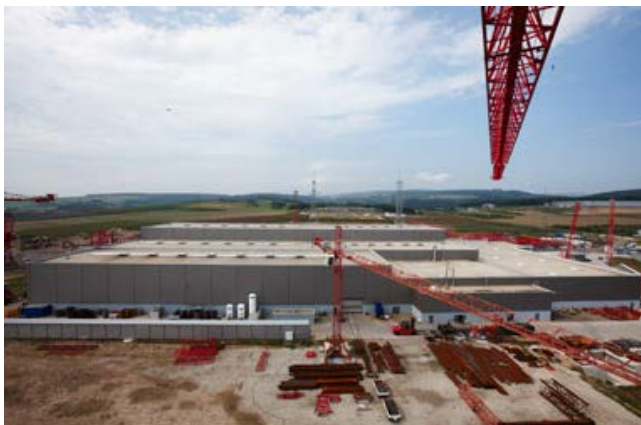
Abb. 1: Blick auf 120 000 Quadratmeter Lager- und Produktionsfläche: Seit 2008 stellt Wilbert im neuen Werk Waldlaubersheim seine Turmkrane mit herausragenden Eigenschaften her
