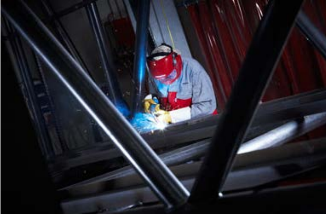
Abb. 3: Diagonalstreben – spitze Winkel der Konstruktion sind für MAG-Brenner oft nur schwer zugänglich. Die Ausnahme: Der druckvolle, richtungsstabile forceArc®-Lichtbogen arbeitet noch mit einem Stick-Out von 40 Millimetern zielgerichtet
