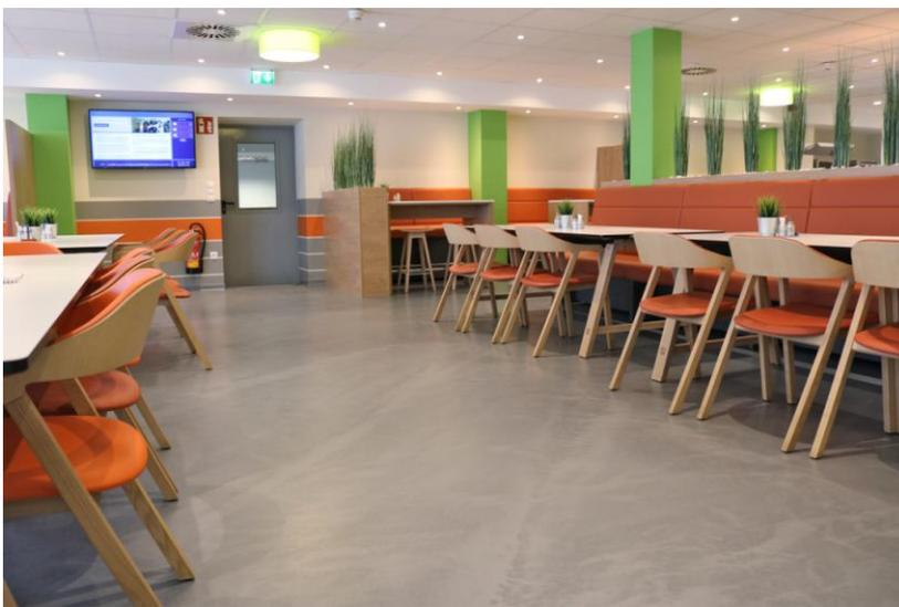
Der neue Kantinenboden bei Remmers muss täglich starken Belastungen stand halten. Das Metalufloor-System von Remmers bietet besten Schutz.
