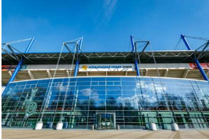
Zuverlässig selbstreinigend: Die Fassade der MSV-Arena mit Pilkington Activ™ . Foto: Severine Groneberg
