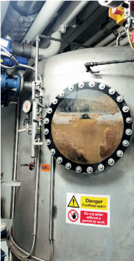
Klären. „Schwarzwasser“, etwa aus den Toiletten, wird besonders aufwendig gereinigt.
