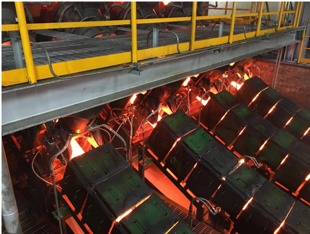
Modernisierte viersträngige Knüppelstranggießanlage von SMS Concast in Betrieb bei Jiangsu Yonggang Group.
