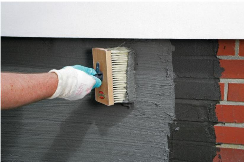
Flexibilität beweist Multi-Baudicht 2K hinsichtlich seines Einsatzspektrums. Es kann zur erdberührten Abdichtung sowohl von Neu- und von Altbauten und auch als Abdichtung unter keramischen Belägen verwendet werden.
