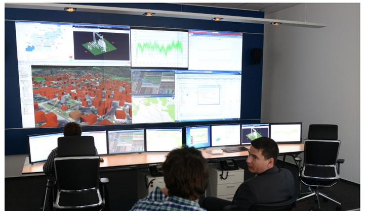
Die Leitwarte selbst kann in zwei Räume aufgeteilt werden, die in einer Notsituation komplett unabhängig voneinander genutzt werden können. Die Aufteilung erfolgt automatisch durch die Schließung einer modularen Trennwand. Ebenso teilt sich das System in zwei Teile und bietet so zusätzliche Vorteile und erweitert die Funktionalität. Die schlüsselfertige Lösung wurde vom RAP-ing Team zur vollen Zufriedenheit von ELES installiert und integriert und wurde im März 2015 in Betrieb genommen.
