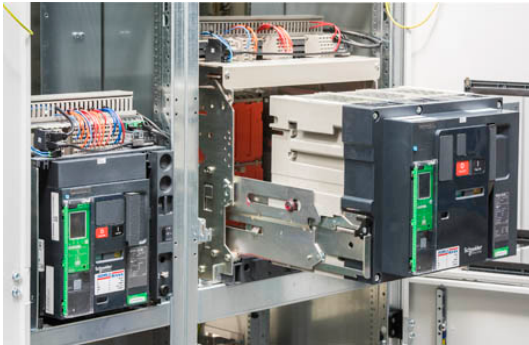
Bild Nr. 47-05 SC_AWB-TY-Auszug.jpg. Mit den Masterpact MTZ von Schneider Electric kommen offene Leistungsschalter der neuesten Generation zum Einsatz.
