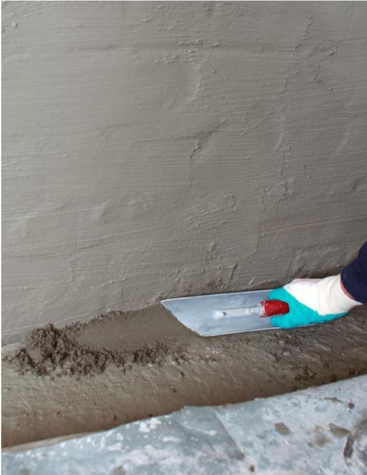
Die Dichtungskehle wird frisch in frisch in die Haftbrücke eingebracht.
