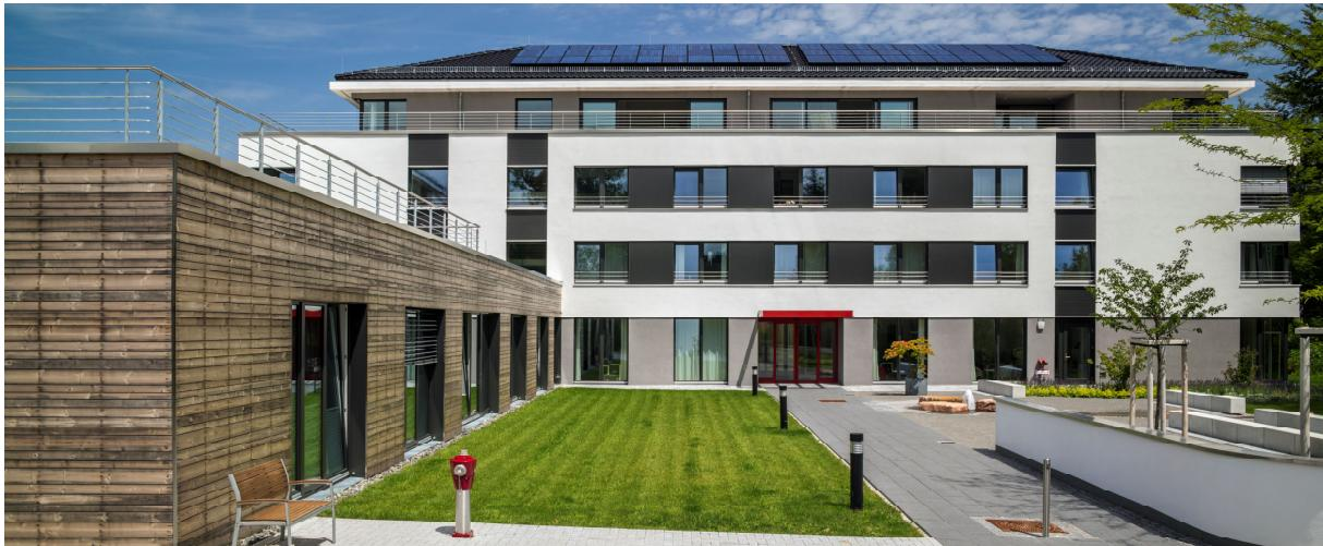
Ein wichtiger Baustein für ein nachhaltiges Gebäude ist die Dämmung der Gebäudehülle. Caparol stattete rund 2500 Quadratmeter Fassadenfläche mit Dämmplatten aus Polystyrol-Hartschaum aus. Die Endbeschichtung erfolgte mit der Fassadenfarbe AmphiSilan.
