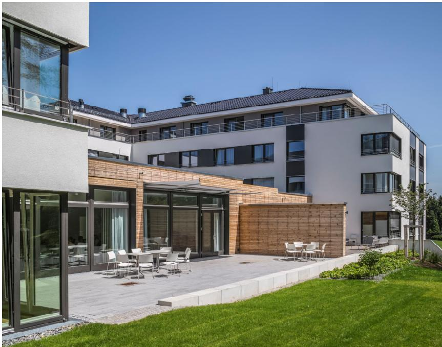
Die verbindenden Flachbauten mit begrünten Dächern zwischen den drei Häusern haben eine reine Holzfassade und sind mit Mineralwolle und Thermoholz verkleidet.
