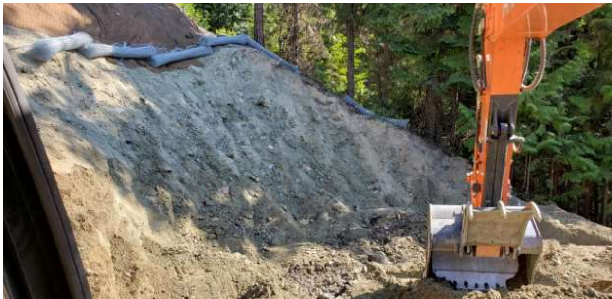
Foto der installierten Abfangwand oberhalb des Abtragungsgebiets.
