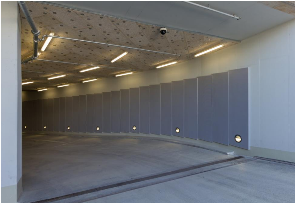
Einfahrtsrampe der Arabeska Tiefgarage in München.
