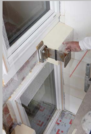
Abb_04: Sorgfältiges Eindämmen der thermisch getrennten Wandaufleger für die Balkone. Foto: puren
