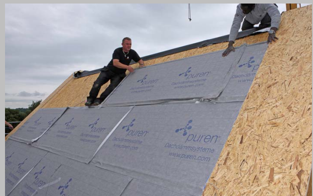
Abb_06: Montage des Steildachdämmsystems puren Plus auf der Holzkonstruktion des Penthauses. Foto: puren
