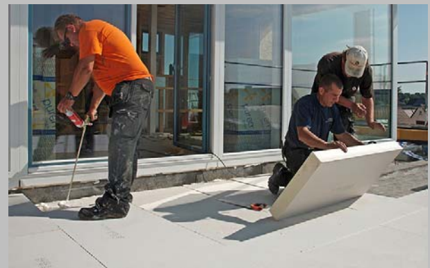
Abb_08: Leistungsfähige puren Flachdachdämmungen kamen für alle Flachdächer zum Einsatz. Foto: puren
