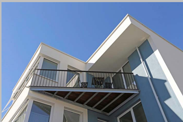
Abb_05: Die neuen Balkone sind thermisch vom Bauwerk getrennt. Foto: puren
