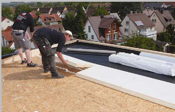
Abb_07: Leistungsfähige puren Flachdachdämmung auf dem Penthouse. Foto: puren
