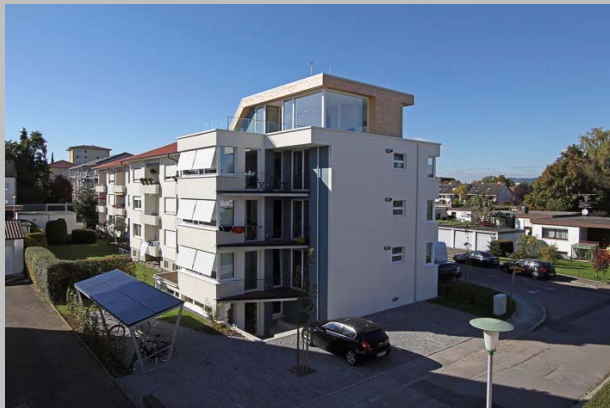
Abb_01: Kernsaniertes Mehrfamilienendhaus in Friedrichshafen: Primärenergieverbrauch durch PU-Dämmungen von 400 auf 12 kWh/m 2 a gesenkt. Foto: puren
