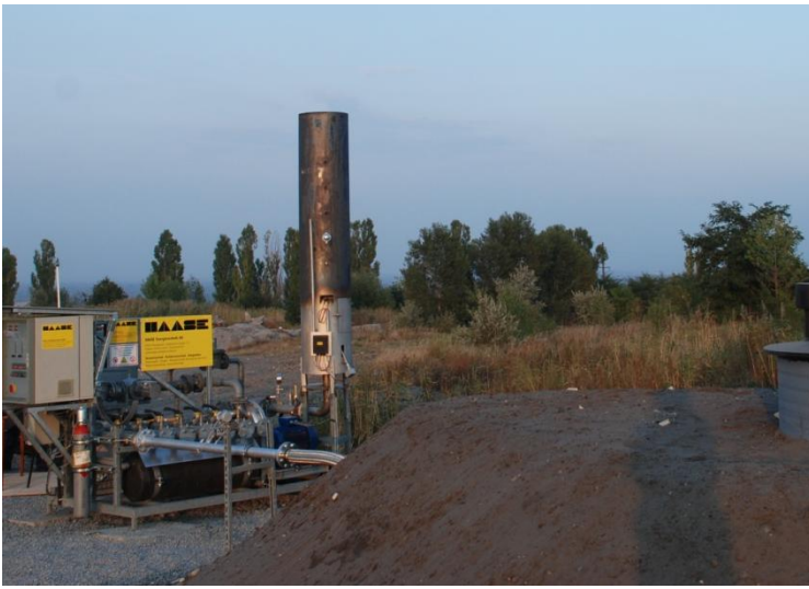
Bild: Deponiegas-Fackelanlage auf der Deponie Kremenschuk, Ukraine
