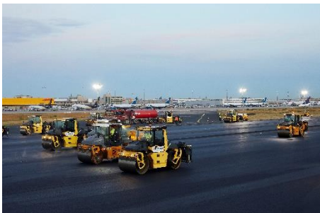
Kosten für Bauprojekte, wie die Sanierung der Start- und Landebahn, werden über MIKA reportet
