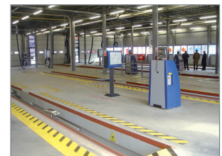
Halle der Prüfstation in Trabzon mit vier Prüfstraßen - am Eröffnungstag
