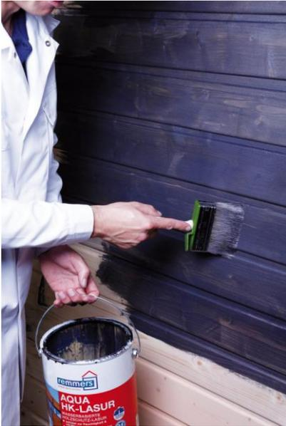
Die Aqua HK-Lasur ist Imprägnierung, Grundierung und Lasur in einem Produkt und überzeugt aufgrund einer schnellen Trocknung.
