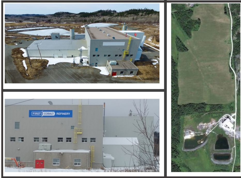
Bild 3. Außen- und Grundstücksfläche der First Kobaltraffinerie
