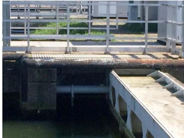
**Überdimensionale Sicherheitsstoßdämpfer im Anstoßbalken in Maasbracht (NL) bremsen bis zu 4.000 t schwere Schiffe bei einer Anfahrgeschwindigkeit von maximal 0,5 m/s und schützen die dahinter liegende Schleusentür**
