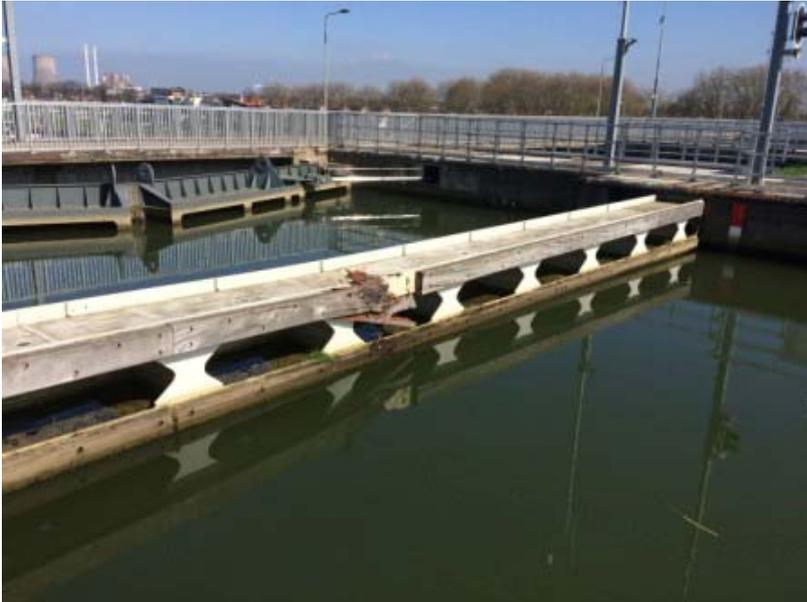
**Anstoßbalken an Schleuse in Maasbracht (NL) nach Kollision mit einem Frachtschiff**
