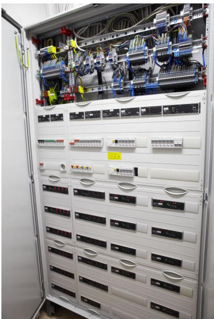
Das Gehirn der intelligenten Haustechnik ist im Keller untergebracht. Die Module für die Haussteuerung sowie Audio- und Video-Server für die Speicherung aller Musikstücke und Filme.
