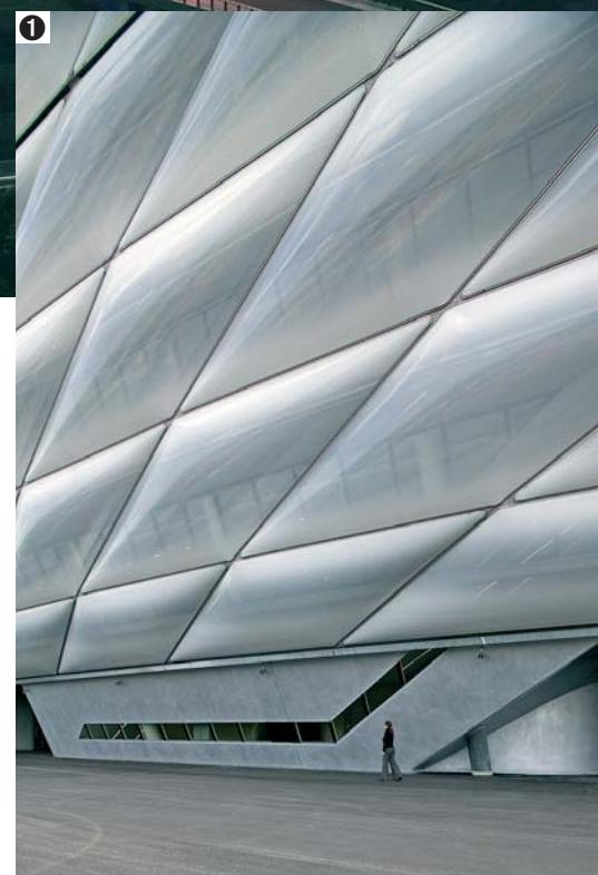
❶ Eine metallisch wirkende Spezialbeschichtung bildet die ideale Basis für die transluzente Hülle.
