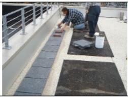
Auf dem vorbereiteten Planum ließen sich die Betonplatten einfach in Reihenlegung mit einem zementfreien Kleber aufkleben.
