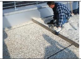
Zum Schluss wurde die Drainageschicht planparallel abgezogen.
