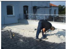
Zum Gefälleausgleich wurde der Drainageestrich in Schichtdicken von 5 bis 27 cm aufgebracht.
