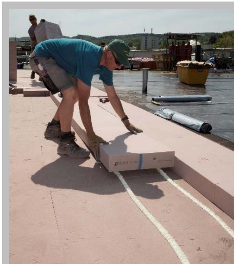
Abb_12: Ein großer Einsatzschwerpunkt für PU-Dämmstoffe ist das Gefälledach. Foto: puren
