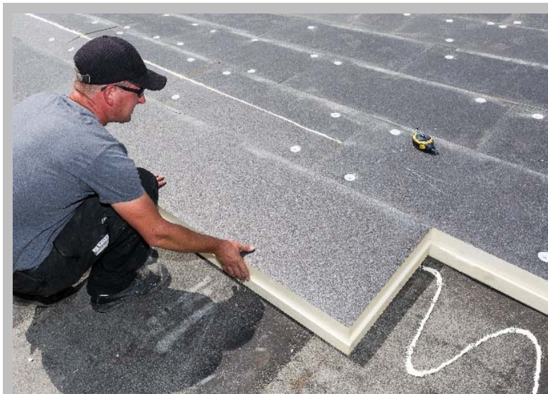
Abb_04: Das schwerentflammbare PU-Flachdach-Dämmelement Secure sichert hohe Dämmleistungen bei geringen Dicken. Foto: puren
