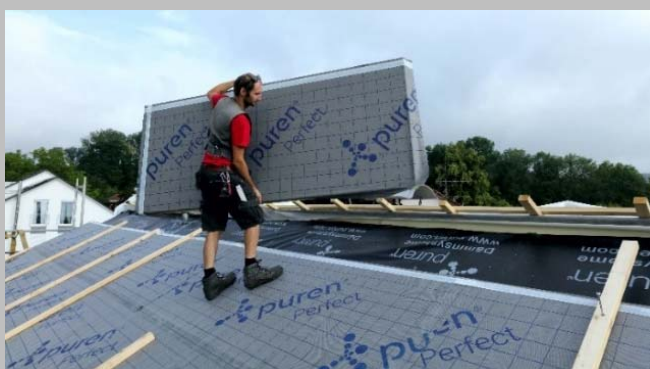
Abb_02: Die neue handliche Aufsparrendämmung puren Perfect. Foto: puren
