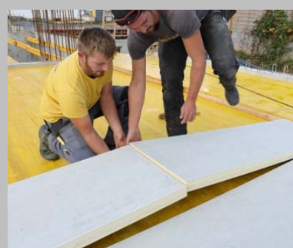
Abb_07: Neue Deckendämmung puren TG im Einbau als verlorene Schalung. Foto: puren
