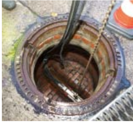
» High-Tech im Einsatz. Für die Kontrolle besonders enger Kanäle setzen die Berliner Wasserbetriebe ferngesteuerte Roboter ein.
