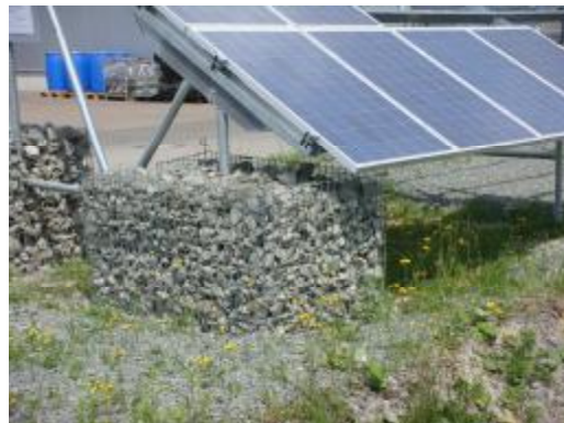
Mittig angeordnetes Gabionenfundament zur zentrischen Krafteinleitung
