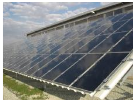
Carport – Solarmodulfläche mit First Solar-Modulen
