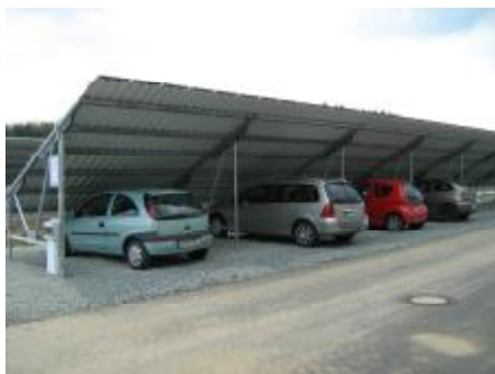
Carport – Stellfläche als Parkplatz
