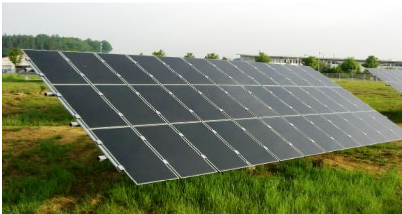
Horizontaltracker mit First Solar-Modulen (ca. 2,61 kwp/Tracker)
