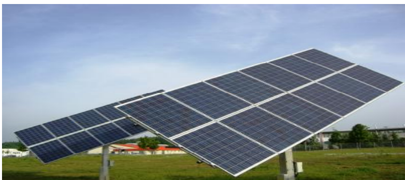
Vertikaltracker mit Silicium-Modulen (2,16 kWp/Tracker)
