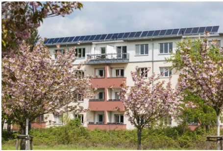
Foto 9: (Ansicht Rückseite mit Balkonen)
