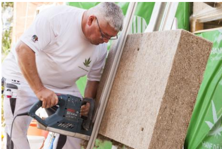
Foto 2: (Dämmplattenzuschnitt)
