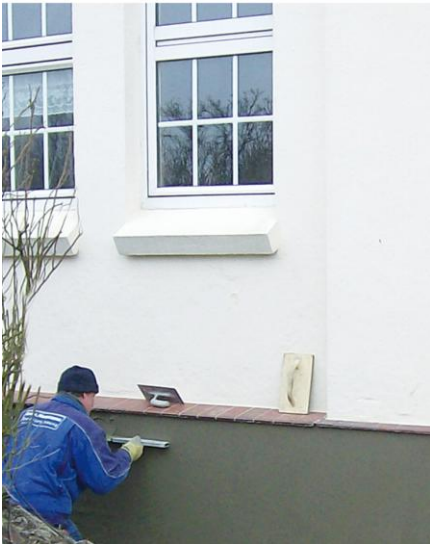
Auftrag von Multi-Baudicht 2K.
