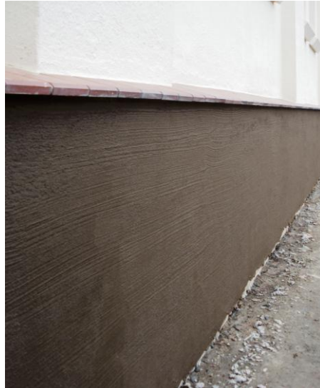
Abgedichteter Sockel mit Multi-Baudicht 2K.
