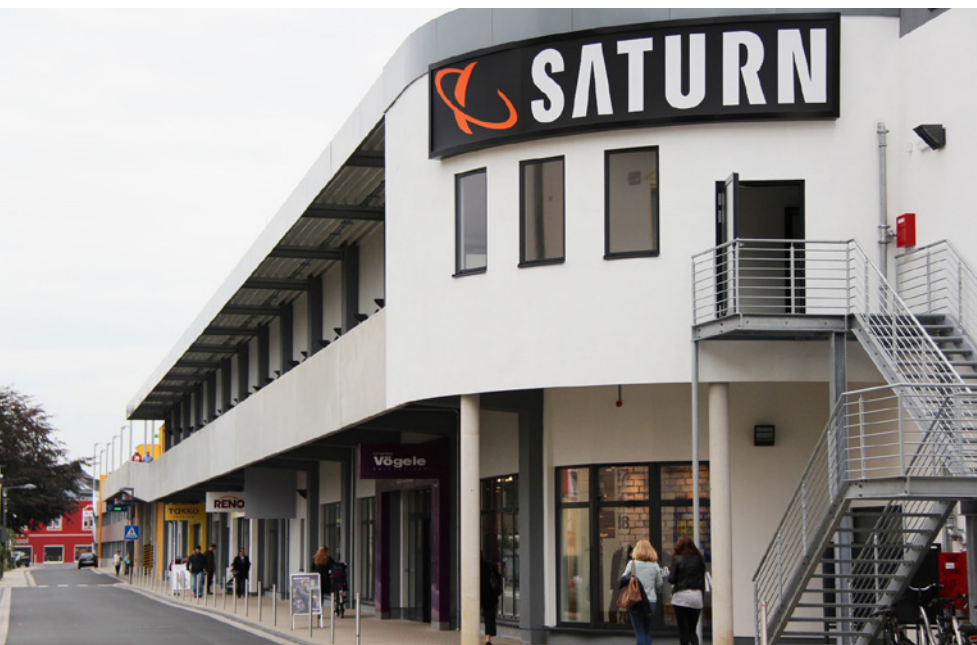
Einkaufszentrum an der Ladestraße in Hennef
