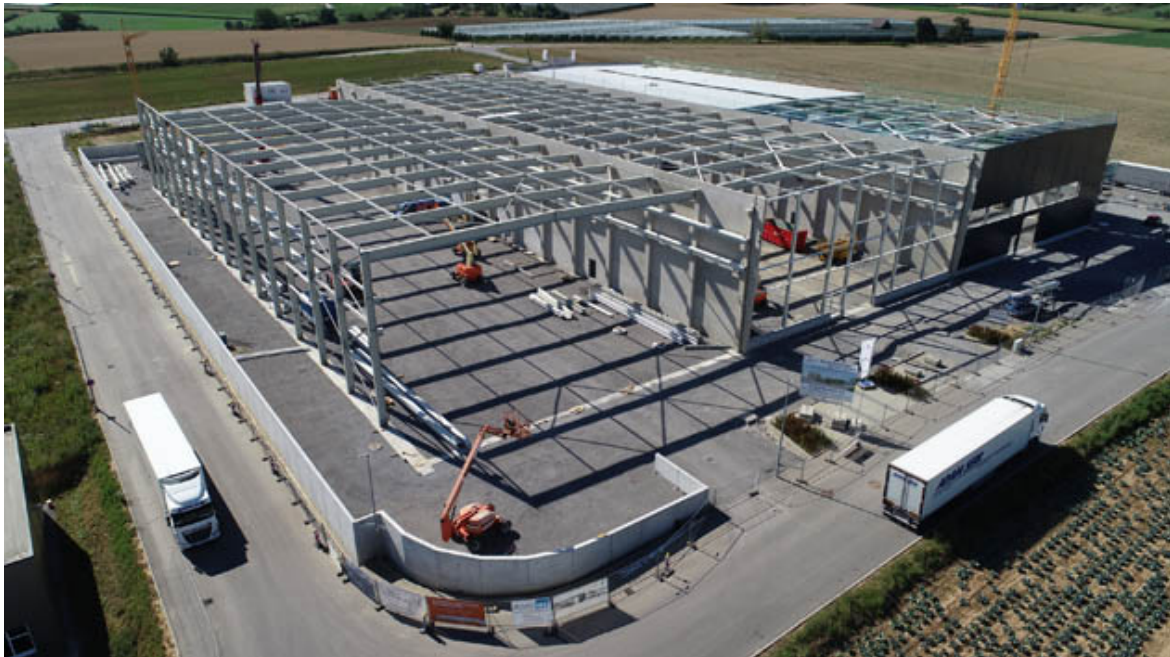
Bild Nr. 12-01 WP_Nebau.jpg, Die Wolpert Gruppe investiert 33 Millionen Euro in den Standort Bretzfeld. Auf dem 27.000 Quadratmeter großen Grundstück entstehen hochmoderne Arbeitsplätze in Produktion und Verwaltung.
