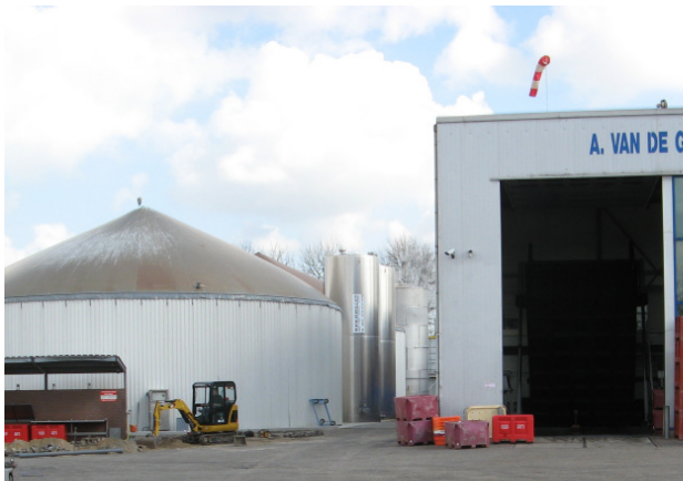
2) PlanET Waste to Energy Biogasanlage integriert in Industriebetrieb
