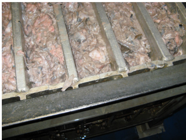
3) Fischreste-Aannahalle für Biogasproduktion
