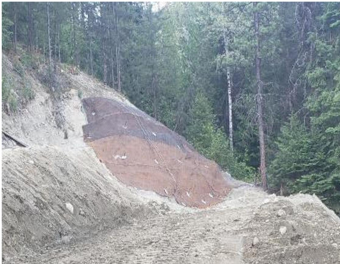
*Foto der vollständig verankerten und gesicherten Böschung oberhalb des Portalstandorts*
