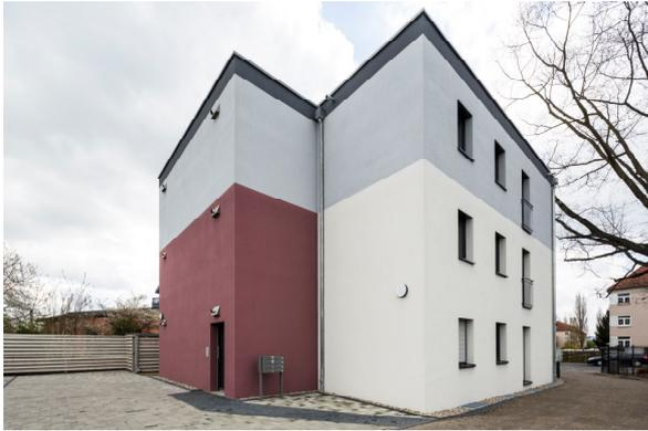
Ein wichtiger Beitrag zum Passivhaus ist die Ausrichtung des Gebäudes, das sich nach Süden öffnet und nach Norden die „kalte Schulter“ zeigt.
