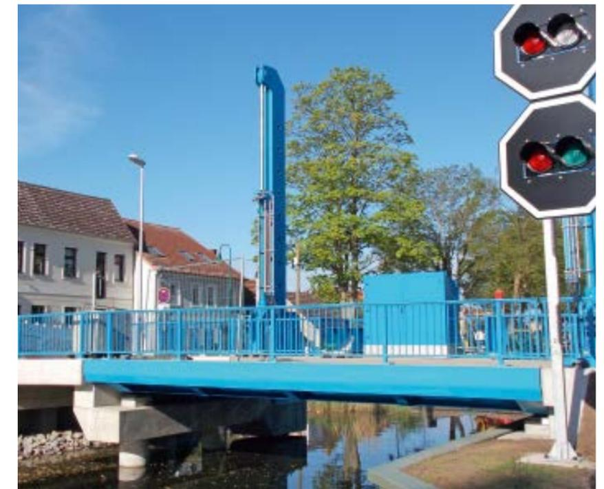
» Eine Herausforderung an Statik und Hydraulik: Die Brückenplatte der Hubbrücke wird von nur zwei großen Zylindern angehoben.
